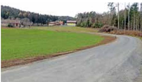
Der **Harrerweg** wurde Richtung Etzendorf ab der Abzweigung Strohsackweg mit einer Spritzasphaltdecke staubfrei gemacht.
